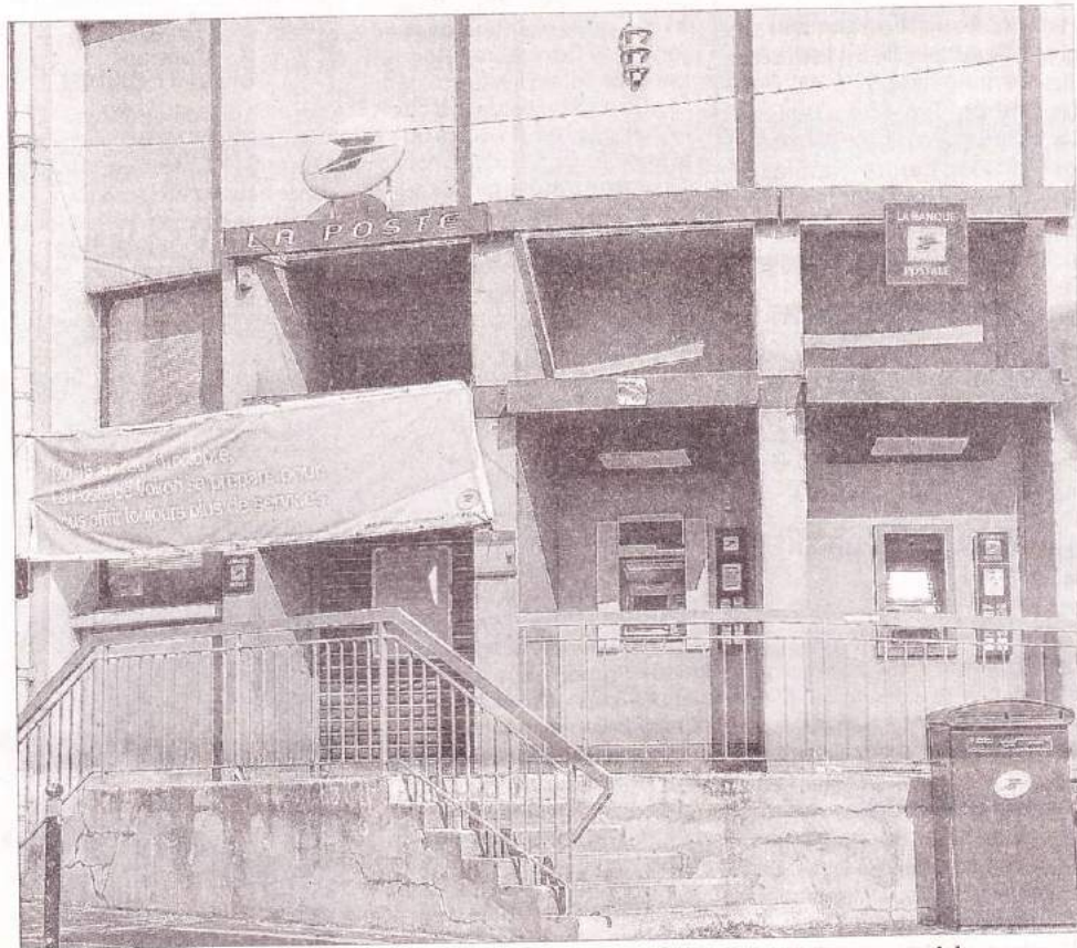
Des affiches et une banderole informent les clients de la fermeture temporaire de l'agence postale avenue Jules-Ravat. Le guichet automatique et la boîte aux lettres installées devant l'entrée fonctionnent toujours.
